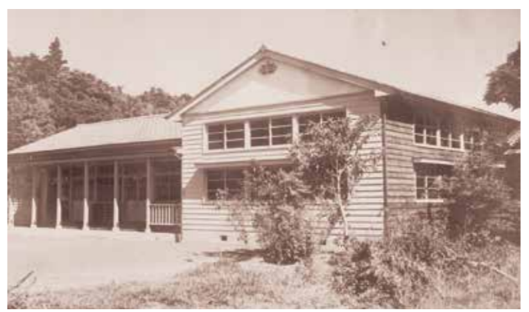
昭和30年建設の木造園舎
