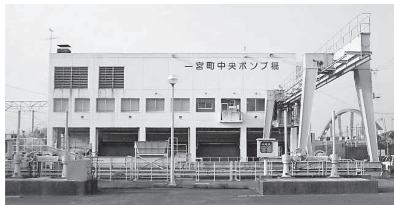
▲④中央ポンプ場
