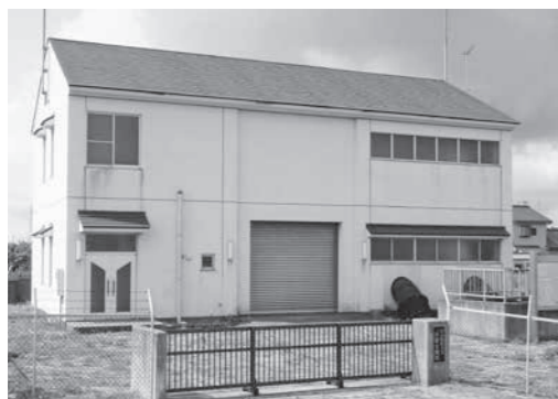
▲⑦一宮排水機場
