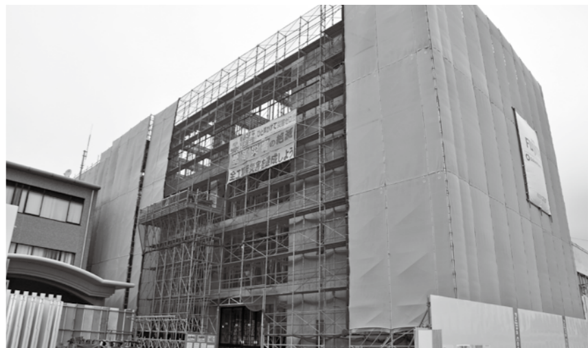
▲完成間近の新庁舎
