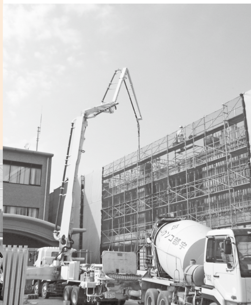
▲コンクリートを庁舎に流しこむ様子
