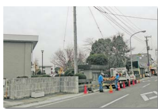
電柱移設作業
