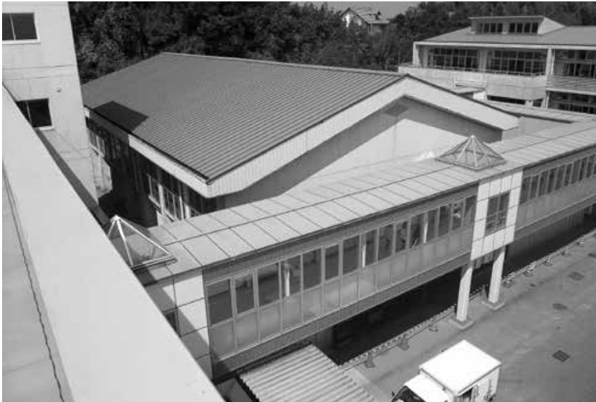
耐震改修が行われる一宮小体育館
