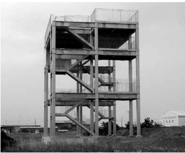
九十九里町の避難タワー
