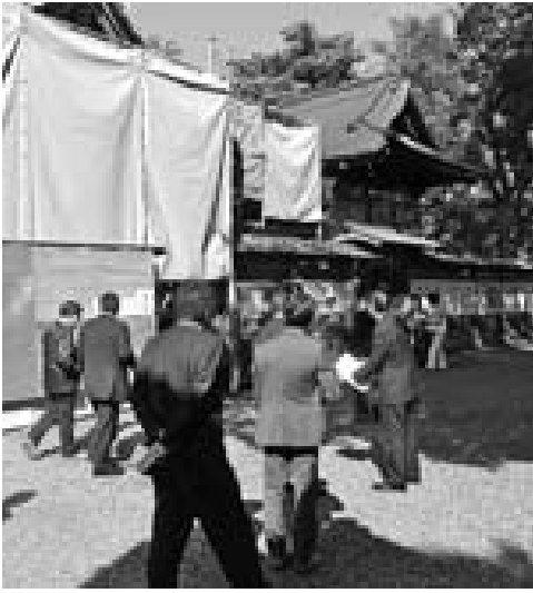
玉前神社社殿改修状況を現場踏査
