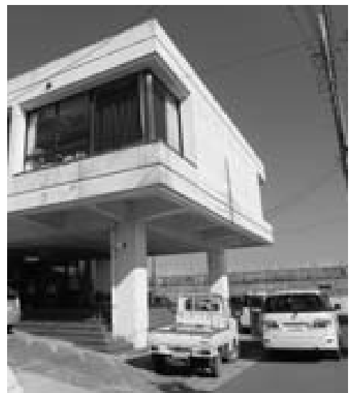
高台への移設が検討される一宮保育所
