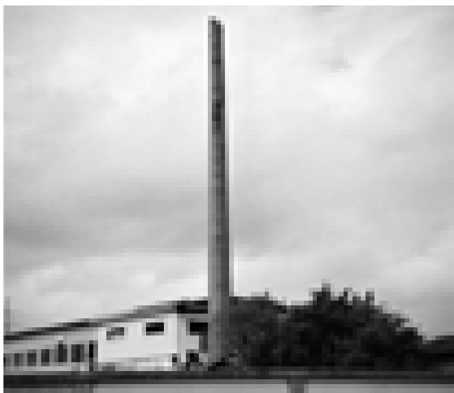
急がれる危険な建物対策（宮原）
