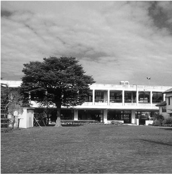
エアコンの設置が待たれる保育所
