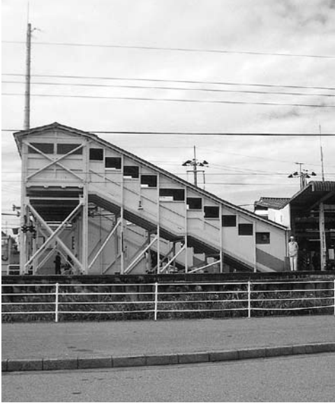
エレベーターが設置される跨線橋
