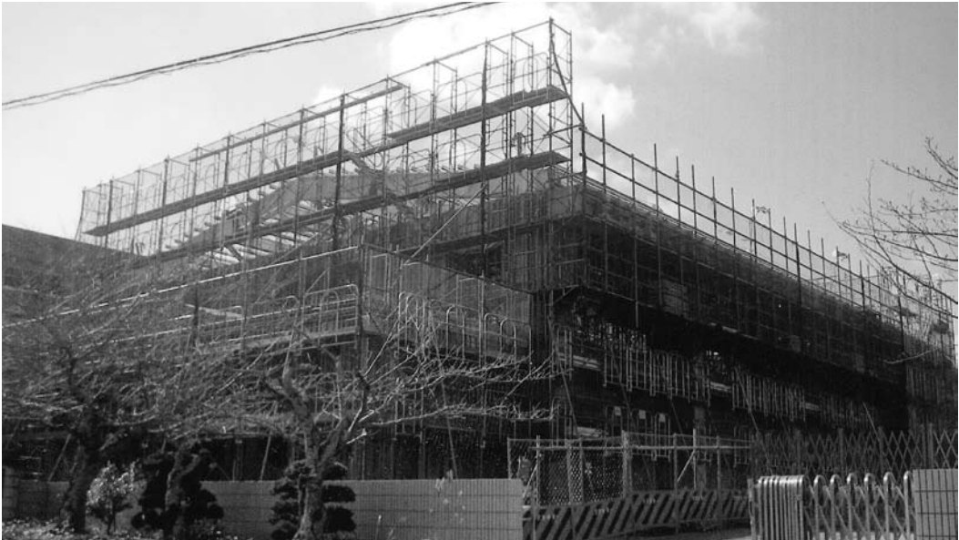
建設が進む一宮中体育館
