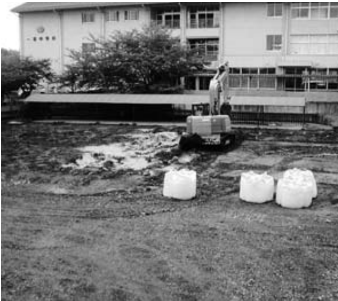
始まった一宮中学校体育館改築工事
