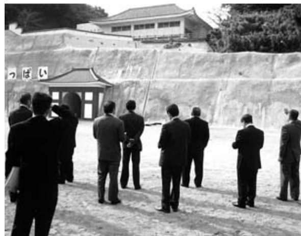
一宮小学校 崩落防止工事（現場踏査）
