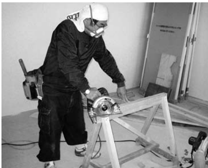
大工職人の作業風景
