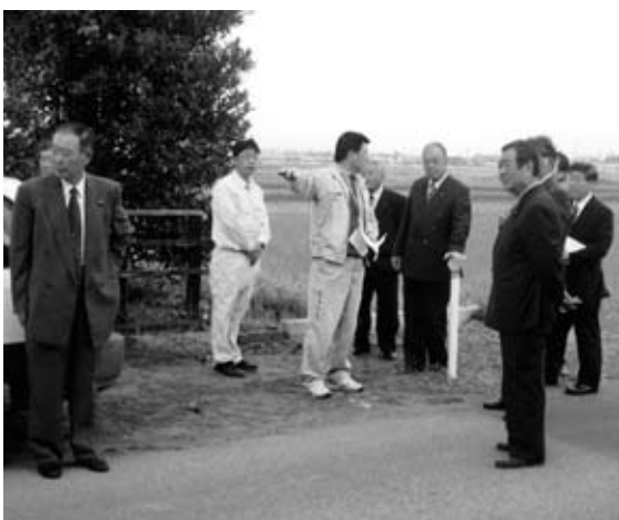
町道 1-10 号線排水整備工事（現場踏査）
