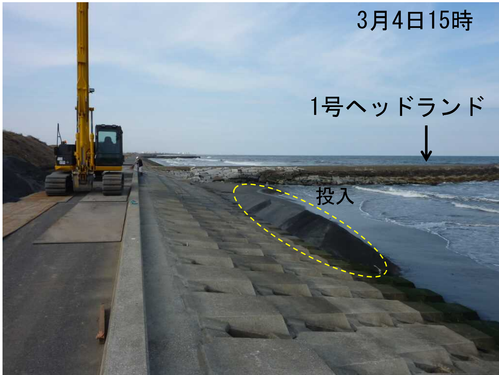
粗粒材の投入状況
