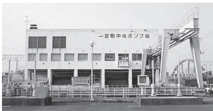
▲④中央ポンプ場
