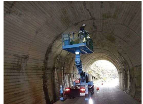
定期点検の状況
