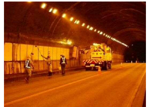
清掃作業の状況
