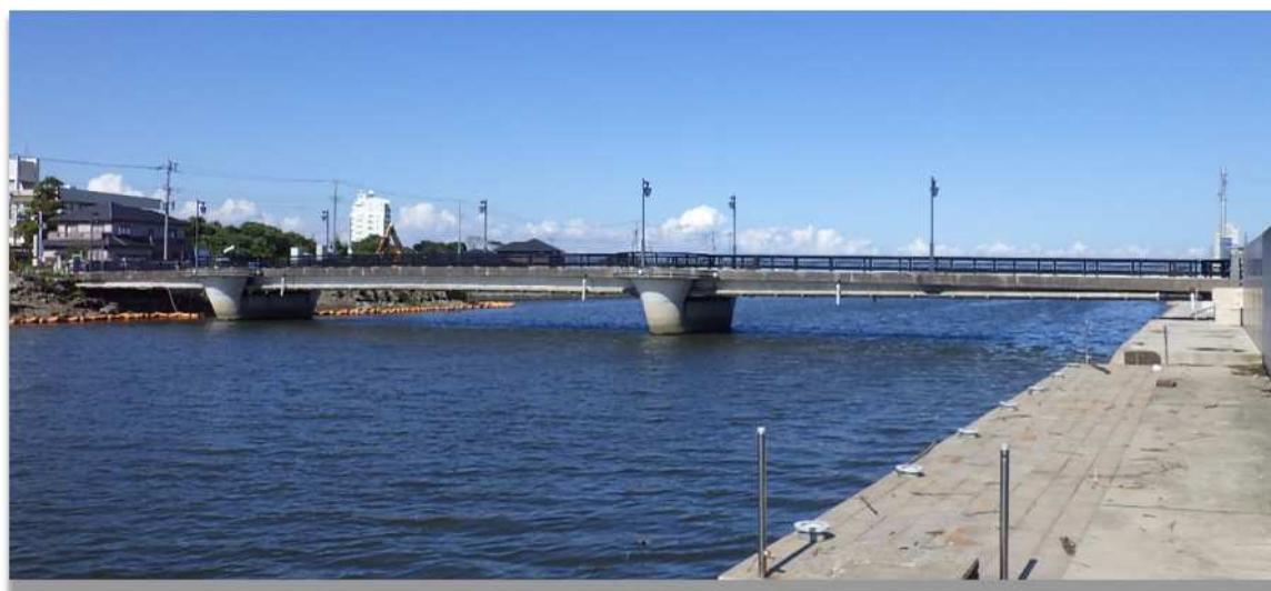
(新一宮橋 撮影：令和4年9月)
