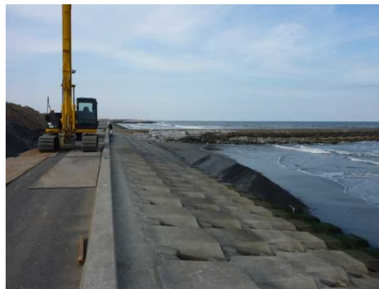
粗粒材の投入状況(投入開始1日後:平成26年3月4日15時)
