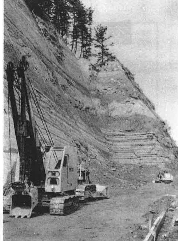
山ぎわの128号線の工事
