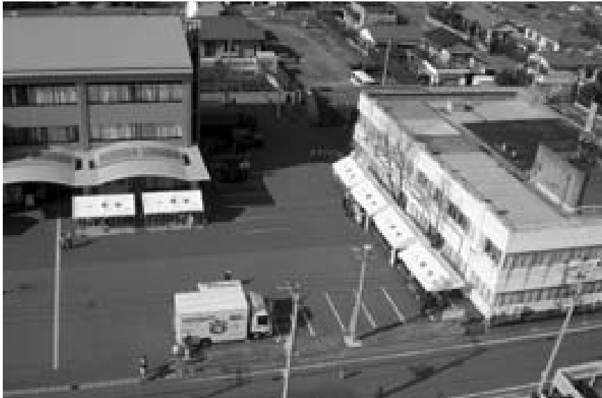
老朽化が進む現庁舎
