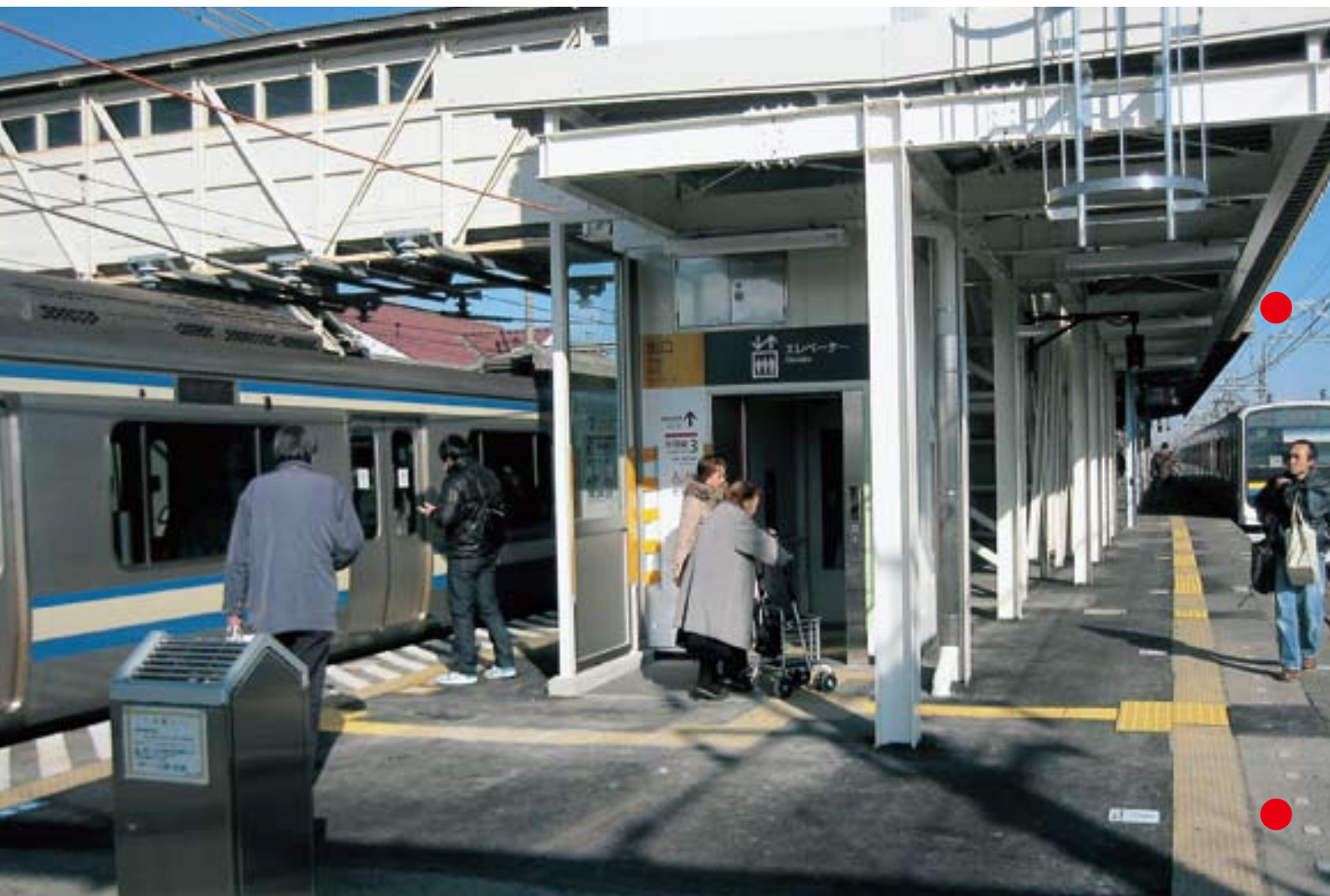
待望のエレベーターが設置された上総一ノ宮駅
