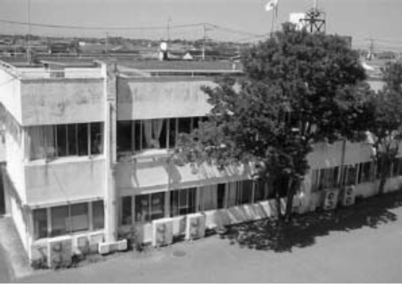
防災を考えた庁舎建設を
