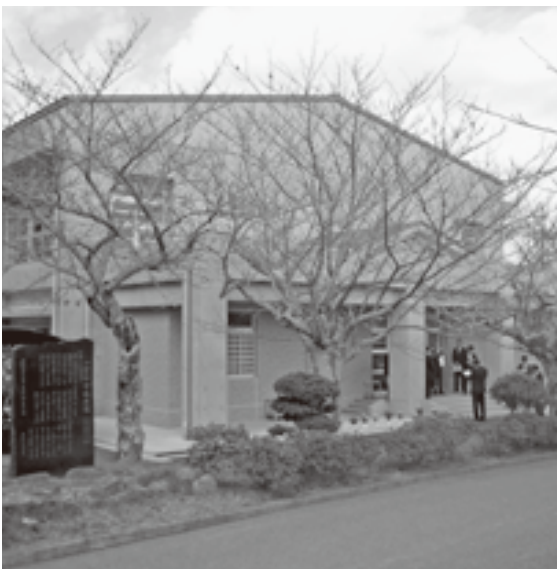
改築された中学校体育館
